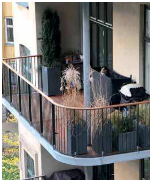
Altanerne bæres af den gennemgående søjle, og det er netop den, som gør det mulig med et stort areal.
